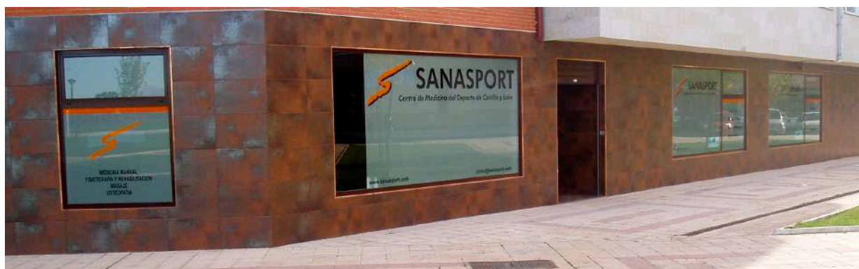
Fachada principal a Avda de Nocedo nº 96
