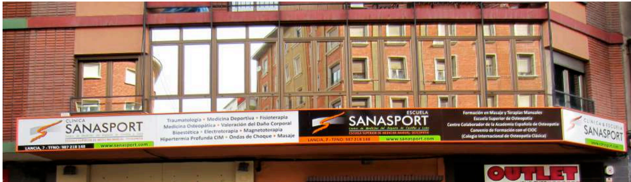
Fachada principal a Avda de Lancia
